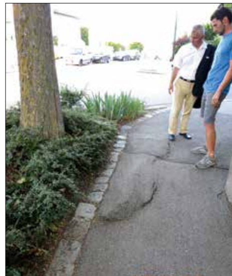
Die Bäume verursachen manches Problem am Gehsteig wie hier in der Josef Leeb-Gasse
